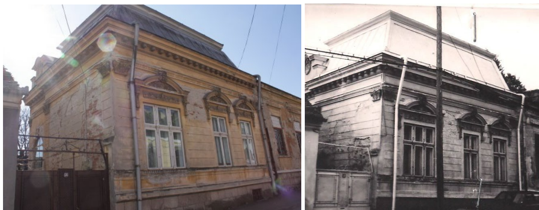
MH-II-m-B-10121 – Str. Aurelian 56
