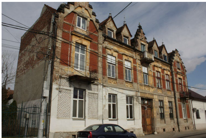
MH-II-m-B-10119 – Str. Aurelian 29
