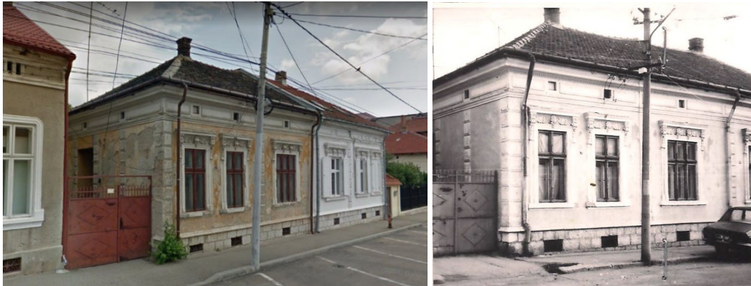
MH-II-m-B-10122 – Str. Aurelian 71
