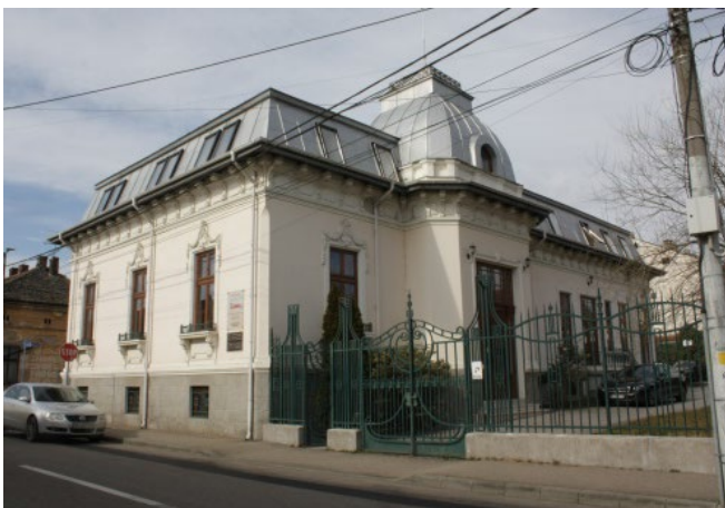
MH-II-m-B-10118 – Str. Aurelian 27
