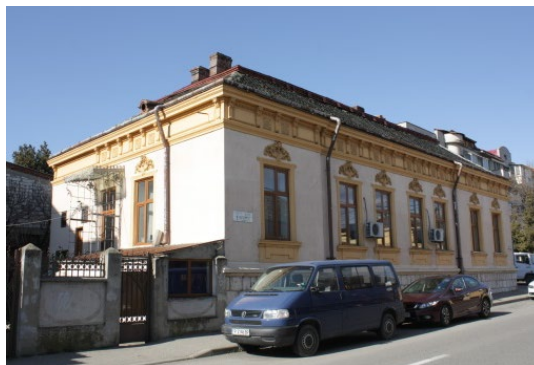
MH-II-m-B-10125 – Str. Aurelian 76
