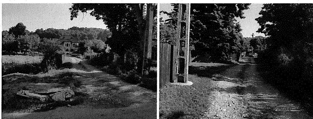
Drumul cu o lungime de 117m cu lățimea existenta de 3.00 – 3.50m, are partea carosabila din balast. În profil longitudinal declivitatea variază între 3.13 – 6.67% .
