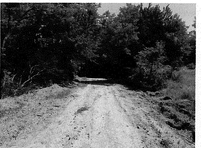
Drumul cu o lungime de 185m cu lățimea existenta de 3.00 - 3.50m, prezintă un drum de pamant. În profil longitudinal declivitatea variază între 2.75 – 11.50% .
