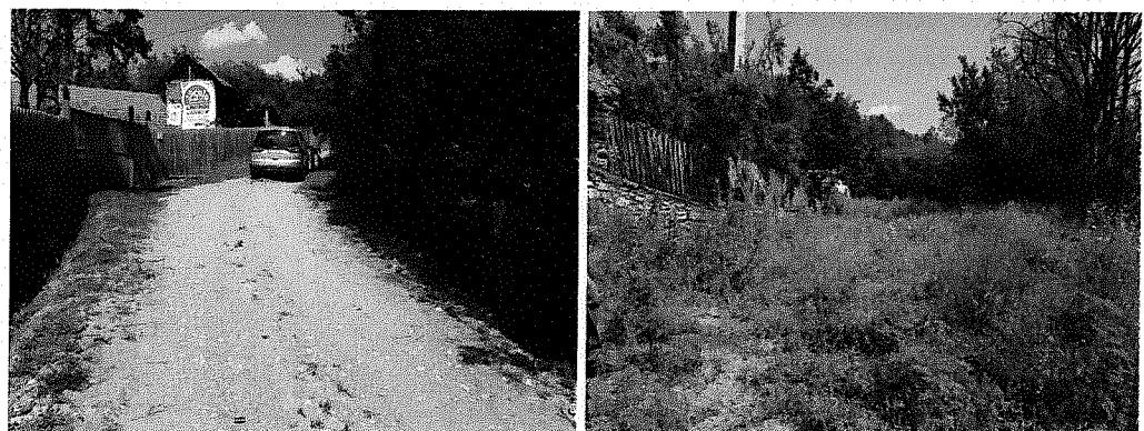
Drumul cu o lungime de 126m cu lățimea existenta de 2.50 – 2.70m, are partea carosabila din balast si pamant. În profil longitudinal declivitatea variază între 1.30 – 11.15% .
