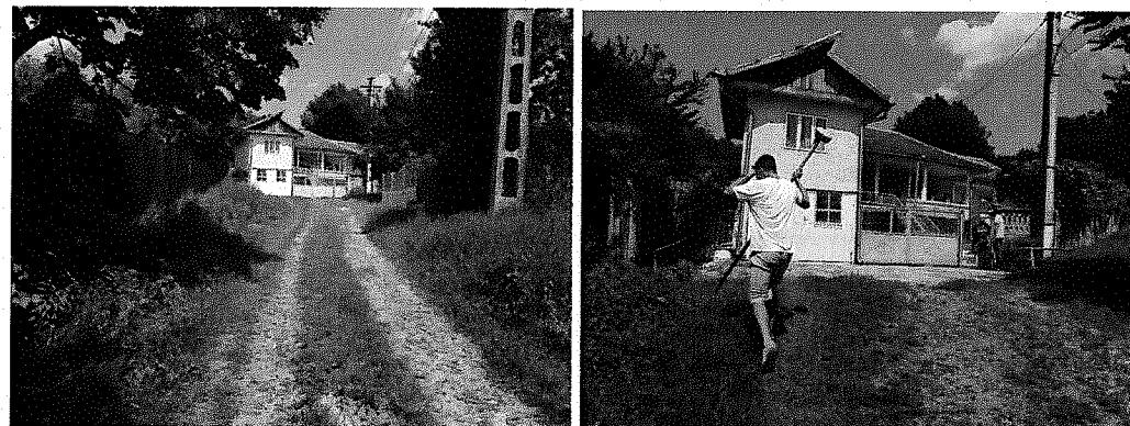
Drumul cu o lungime de 70m cu lățimea existenta de 2.50m, prezintă un drum de pamant. În profil longitudinal declivitatea variază între 1.03 – 10.72% .
