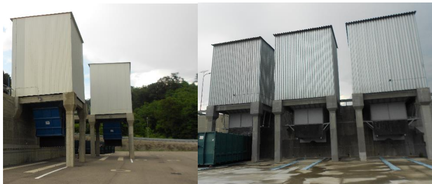
Figura 7-10 Exemplu de transfer prin intermediul unor tobogane în containere deschise
