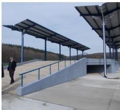
Figura 7-11 Stații deschise de transfer
