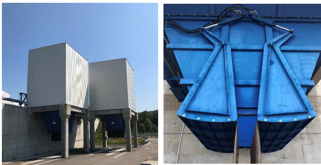
Figura 4-10 Stația de transfer Baia de Aramă
